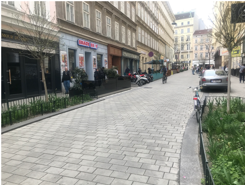
Abbildung 8: Betonsteine in der Otto-Baugasse. Auch hier sind die Steine mit wasserdurchlässigen Fugen verlegt
