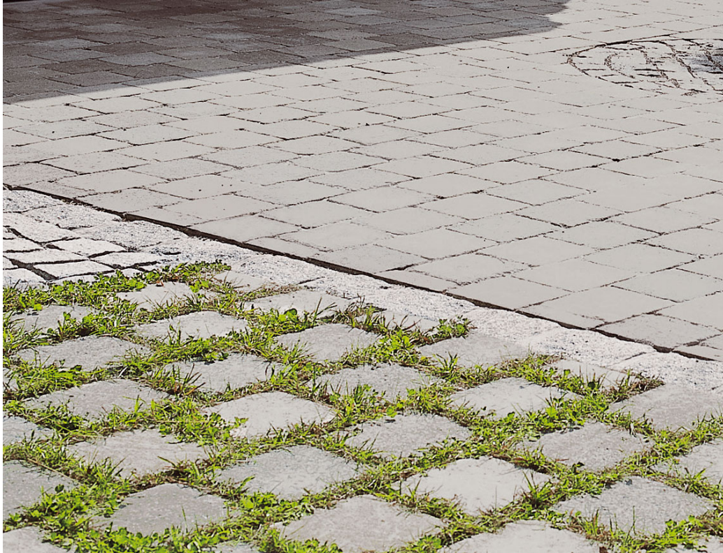
Abbildung 5: Großsteinflaster mit Rasenfuge (vorne), Betonsteine mit Splitfuge (hinten)
